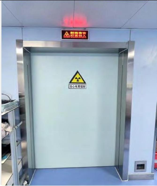
患者出入口设置的放射性标志、中文警示说明和“射线有害灯亮勿入”警示灯，以及脚踏式门口开关。
